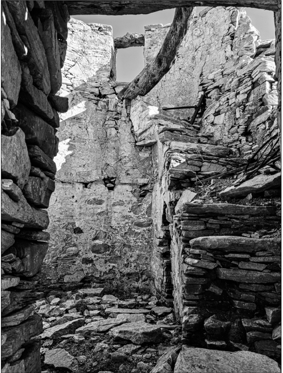
Εσωτερικό μύλου (Πάρος), φωτ. Πάνος Κέκας.
