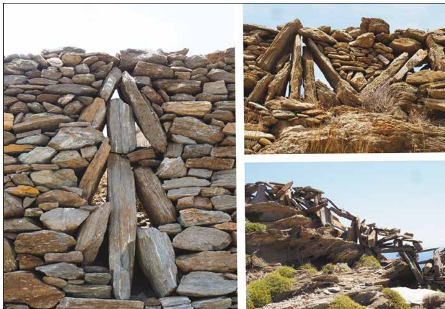
Εικ. 1: Περίτεχνοι ξερολιθικοί τοίχοι οριοθέτησης.
